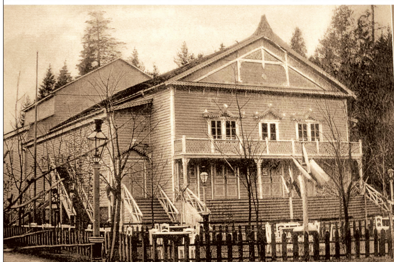
Teatr letni w Zwierzyncu: projekt elewacji frontowej, 1897 rok i widok ogólny budynku, fot. z początku XX wieku
