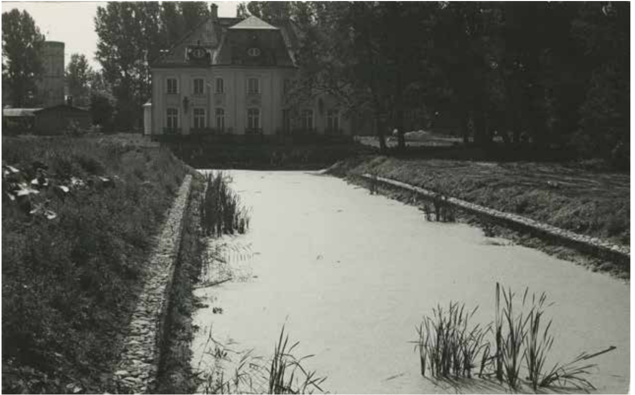
Konserwacja głównego kanału, fot. A. Ciulkin, 1985
