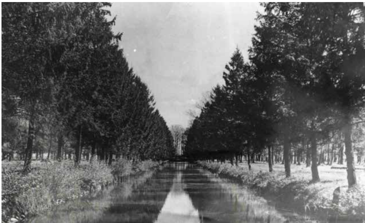
Zachodnie ramie kanału krzyżowego, fot. J.Glinka, 1937, Teki Glinki
