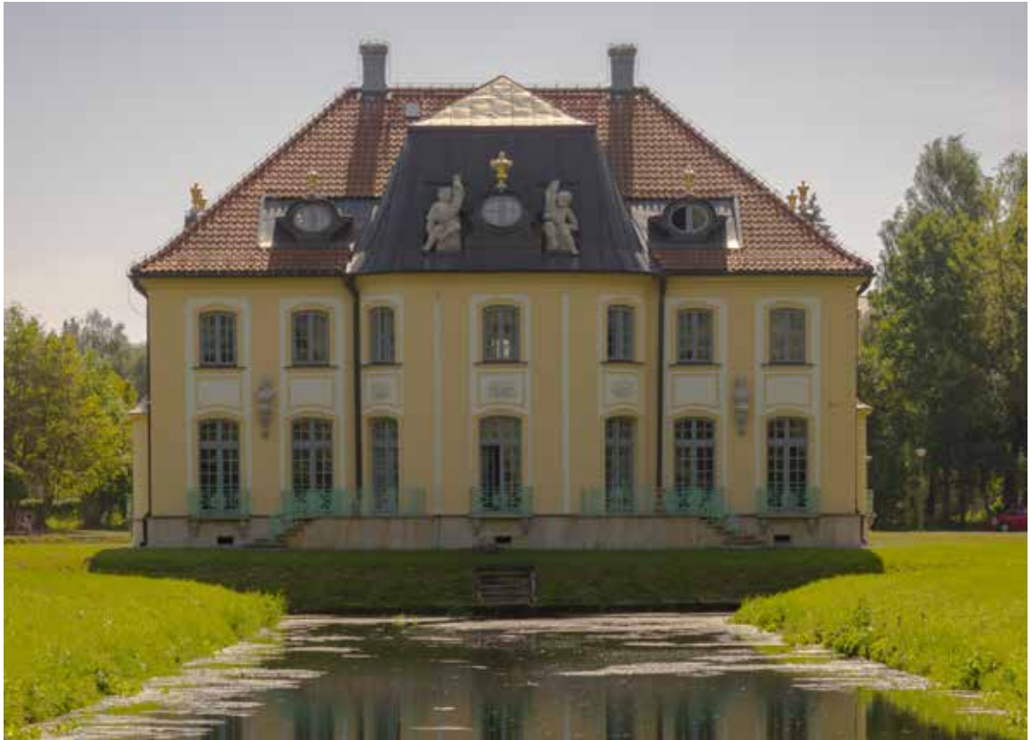
Pałac, elewacja ogrodowa, fot. I. Malesińska, 2023
