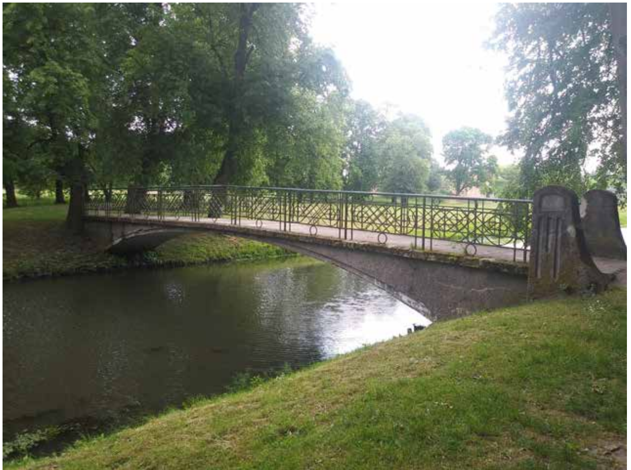
Mostek żeliwny na osi głównej, fot. A. Dąbrowska, 2024
