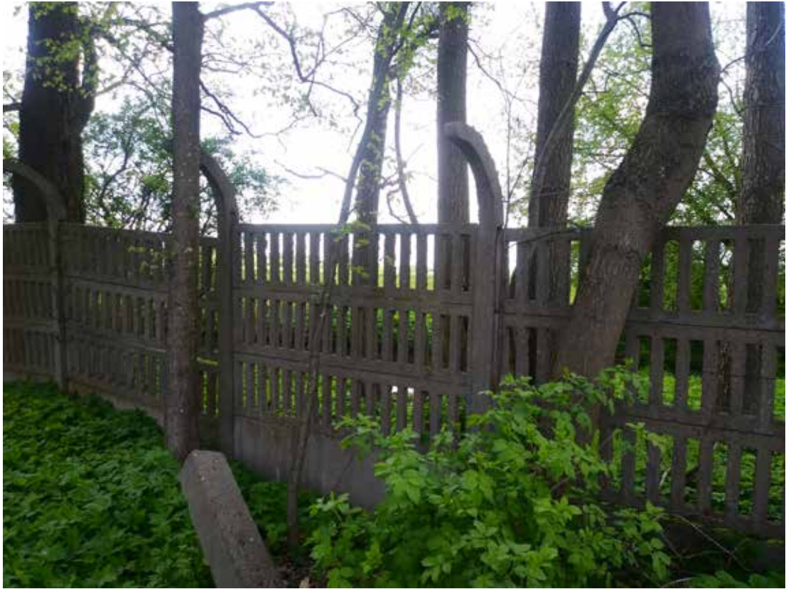
Pozostałości ogrodzenia z płyt betonowych, fot. A. Dąbrowska, 2024
