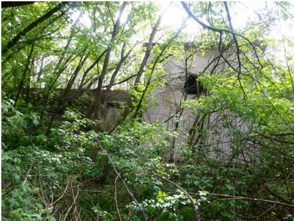
Nieczynna oczyszczalnia ścieków, fot. A. Dąbrowska, 2024
