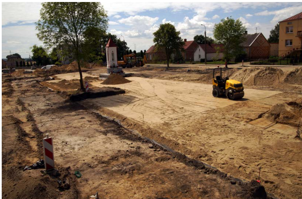
Ryc. I.12. Suraż, stan. 2 i 7. Prace budowlane na terenie rynku (widok od północnego wschodu). Lipiec 2018 r. Fot. D. Krasnodębski
